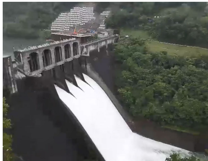
新丸山ダム 現場LIVE映像
