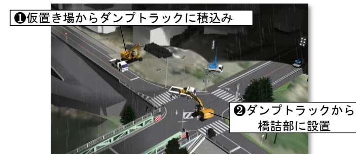
図-7 大型土のう設置訓練
