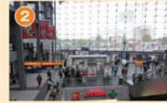
ベルリン中央駅 広く開放的でわかりやすい空間構成
