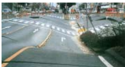
●阪神・淡路大震災(H7.1)によって通行不可能となった道路(神戸市大開駅付近)
