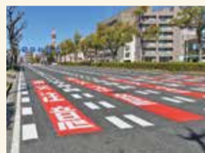
交通安全対策 <カラー舗装>
