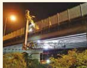
道路橋の点検
