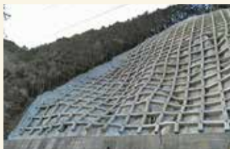
法面の防災対策
