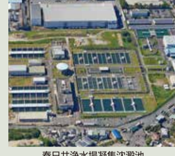
春日井浄水場凝集沈澱池(名古屋市)
