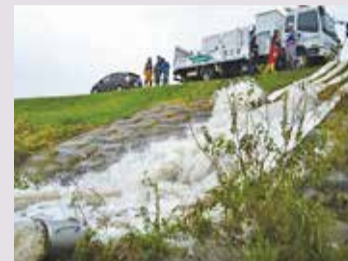
③ 排水ポンプ車による排水作業(迅速な復旧に向けた支援)
