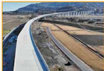
養老IC～いなべIC間 工事状況
