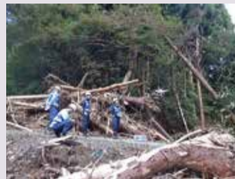
②-2 ドローンによる被災状況調査(被害情報を迅速に把握)
