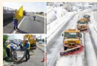
巡回・清掃・除雪作業
