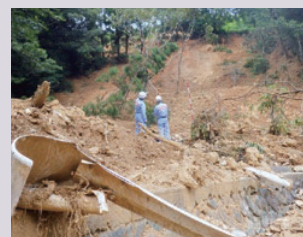
被災状況調査(愛媛県大洲市)
