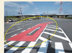
幹線道路の事故対策 <カラー舗装>
