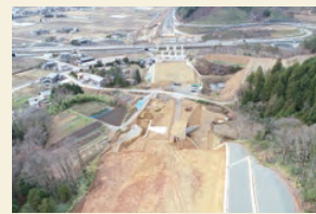
国道158号高山清見道路 工事状況 中部縦貫自動車道
