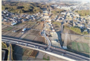
国道1号北勢バイパス 工事状況 国道1号北勢バイパス
