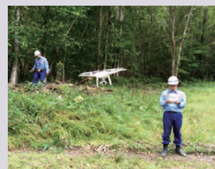
ドローンによる被災状況調査(北海道厚真町)
