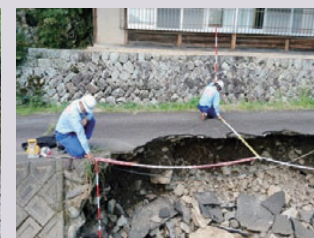
被災状況調査(岐阜県関市)
