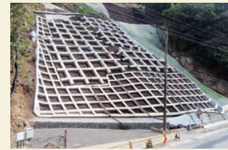
法面の防災対策
