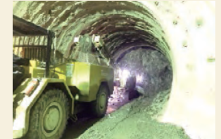
国道474号青崩峠道路 工事状況
