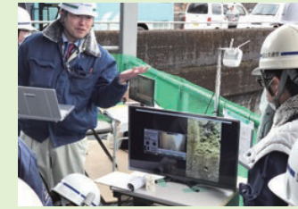
水中点検ロボットによる放流設備調査(丸山ダム)
