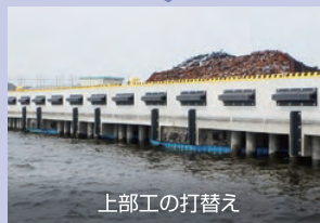
防舷材の欠損、上部工の劣化
