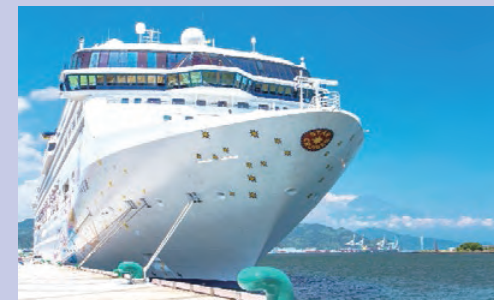
大型クルーズ船に対応した岸壁の整備(清水港 日の出地区)
