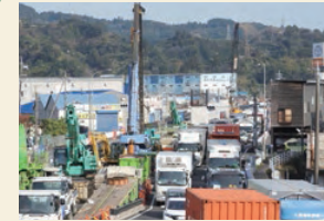
国道1号静岡バイパス 工事状況 国道1号 静岡バイパス
