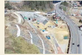
国道41号石浦バイパス 工事状況 国道41号 石浦バイパス
