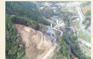
国道414号河津下田道路(Ⅱ期) 工事状況 伊豆縦貫自動車道
