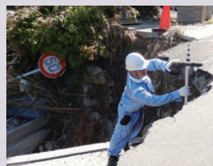
被災状況調査(愛媛県愛南町)
