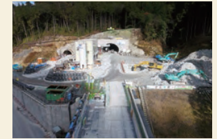
国道474号佐久間道路・三遠道路 工事状況 三遠南信自動車道
