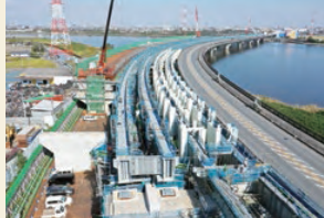
名古屋環状2号線(名古屋西～飛島) 工事状況 近畿自動車道伊勢線
