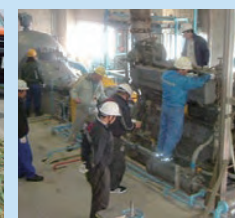
機械設備の保守点検
