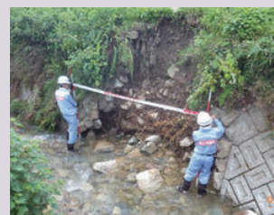
被災状況調査(岐阜県下呂市)
