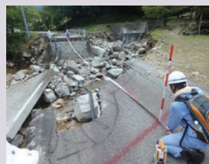
被災状況調査(岐阜県下呂市)
