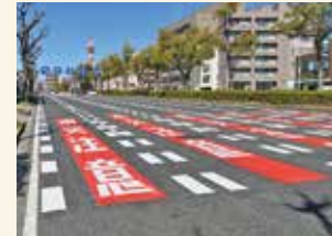
交通安全対策<カラー舗装>
