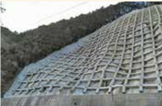
法面の防災対策
