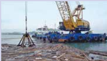
浮遊物・障害物除去作業
