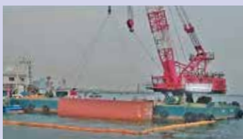
コンテナ撤去作業
