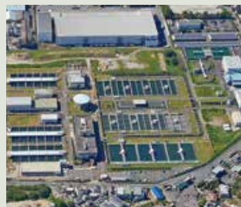
春日井浄水場凝集沈澱池（名古屋市）
