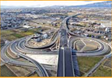
本巣IC付近の工事状況
