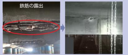
栈橋式岸壁の老朽化状況と対策
