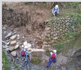
護岸崩落箇所の調査 (川根本町)
