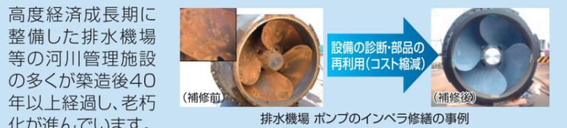
高度経済成長期に整備した排水機場等の河川管理施設の多くが築造後40年以上経過し、老朽化が進んでいます。このため、経年劣化等により機能が低下した河川管理施設等を点検結果に基づきトータルコストの削減に努めつつ整備・更新を行っています。また、管内には国が洪水調節や利水補給をしているダムが9基あり、適確な流水管理と、機能を十分に発揮できるように維持管理を行っています。
