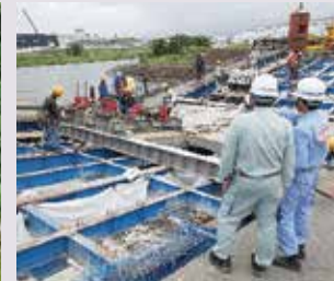
橋梁復旧工事の技術指導
