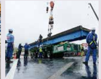
橋梁復旧工事の技術指導
