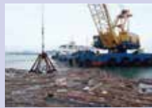
浮遊物・障害物除去作業
