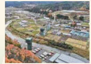
中部縦貫自動車道
