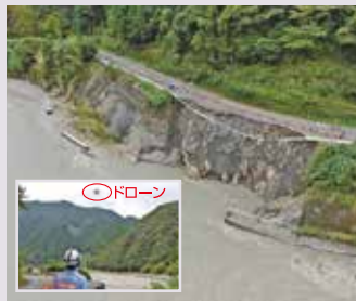
ドローンによる被災状況調査 (静岡市葵区)
