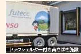
ドックシェルター付き荷さばき施設
