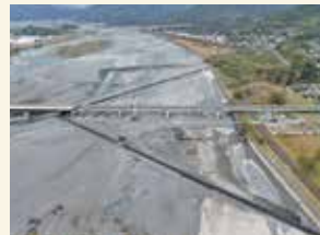
国道1号 島田金谷バイパス 令和6年度部分開通予定
