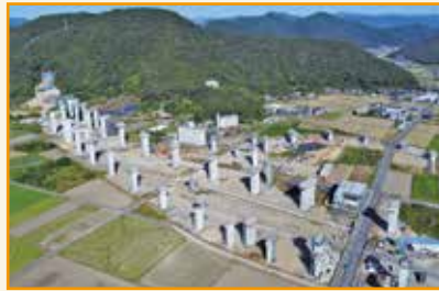
岐阜IC(仮称)付近の工事状況
