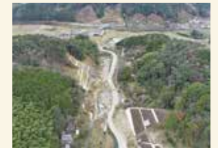
河津下田道路(I期・II期) 伊豆縦貫自動車道
