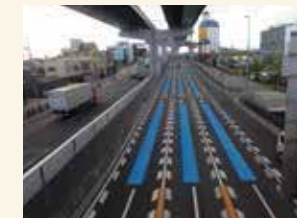
交通安全対策 <カラー舗装>
