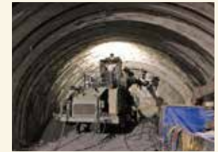
青崩峠道路 三遠南信自動車道 令和7年度部分開通予定
