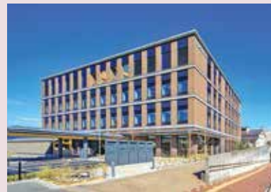
▲高山地方合同庁舎 (令和2年度完成)
