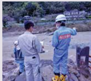
仮設橋の架設計画等の技術支援 (静岡市清水区)
