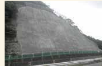
法面の防災対策
