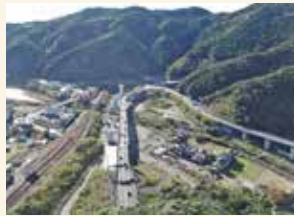
熊野道路 国道42号 熊野道路 国道42号 紀宝熊野道路
