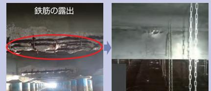
桟橋式岸壁の老朽化状況と対策
