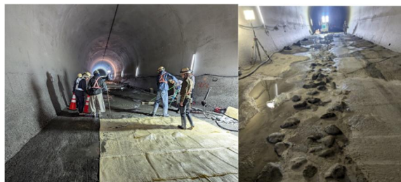
図-17 部分補修施工の状況
