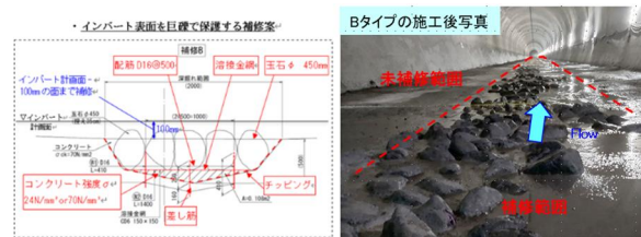
図-12 補修Bタイプの仕様と補修状況
