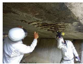
鉄筋露出部の簡易防錆
