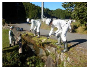
床版端部の清掃
