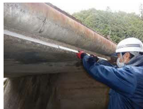
水切り材の設置
