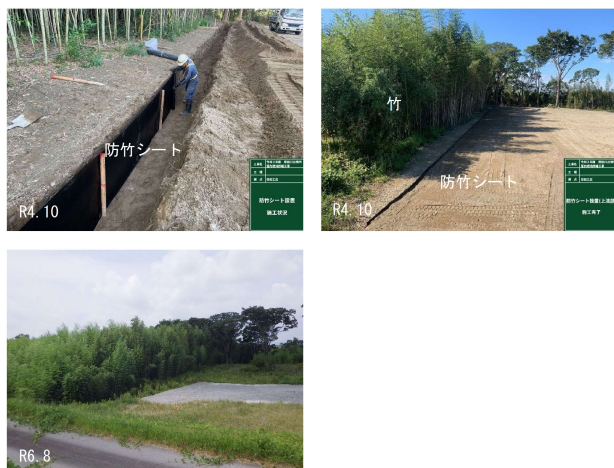
図8 櫛田川右岸 8.3k～8.7k 伐採＋除根＋防竹シートの状況
