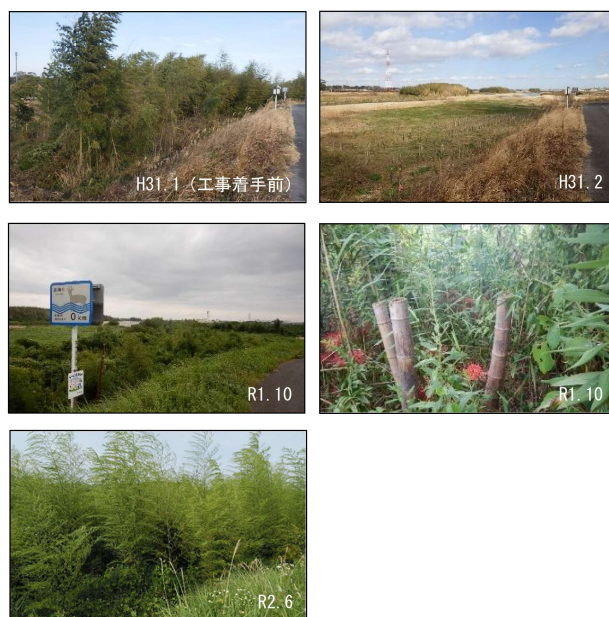
図7 鈴鹿川左岸 15.0k 1m刈り残り伐採の状況
