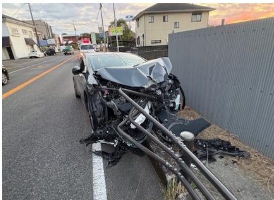
写真-1 道路損傷の例
