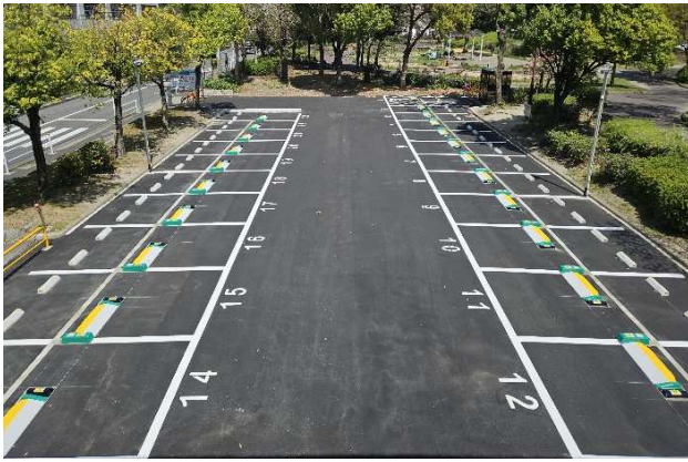
図-6 改修・設置工事完了
