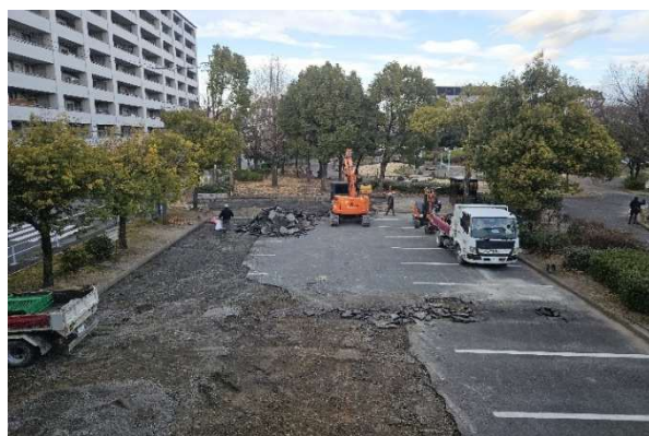
図-5 舗装の打ち替え工事
