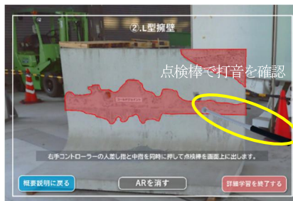
写真-3 損傷部の明示
