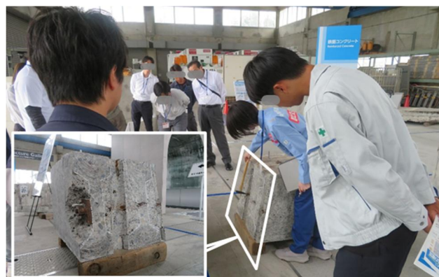
写真-8 損傷部材から施工の留意点を学ぶ
