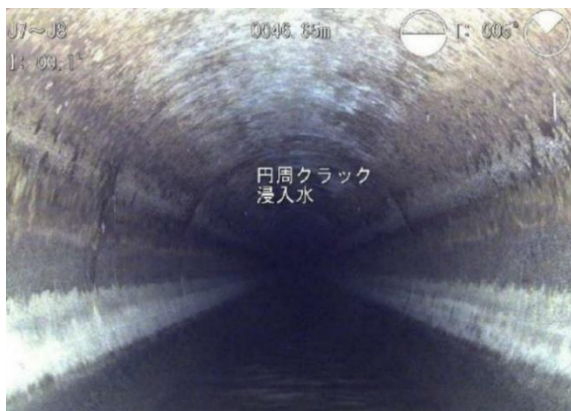
写真-3 自走式テレビカメラの撮影例
