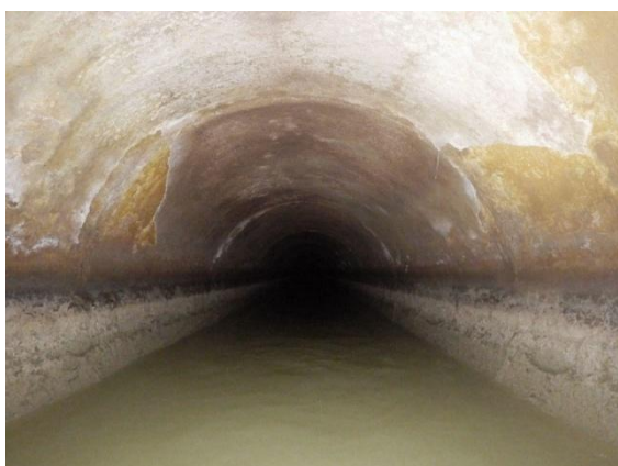
写真-6 ドローンを活用した点検の撮影例
