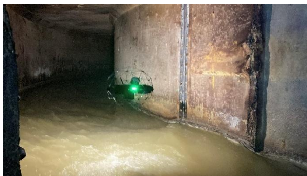
写真-5 ドローンを活用した点検の状況
