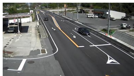
写真-3 右折レーンの設置
