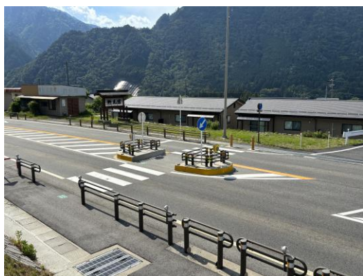
写真-4 二段階横断施設の設置
