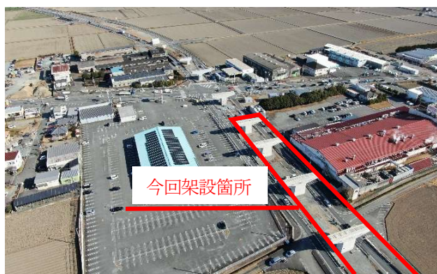
写真-2 朝田南交差点全景(架設前)
