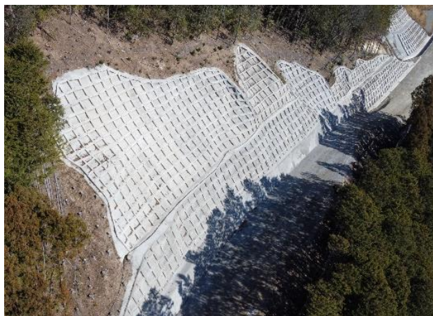
図-2 崩落前の状況（2022年1月20日）
