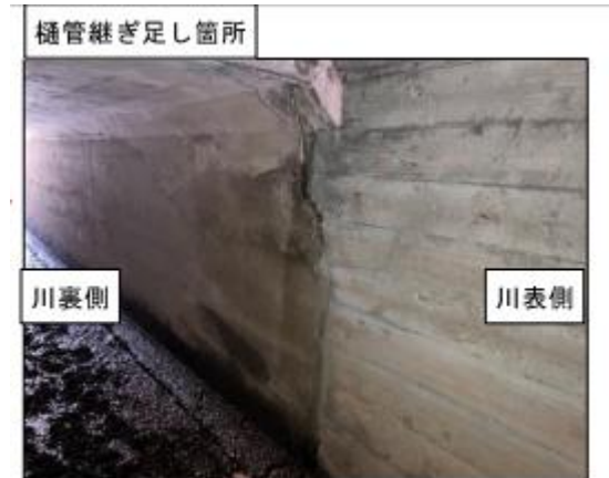
図-2 樋管継ぎ足し部
