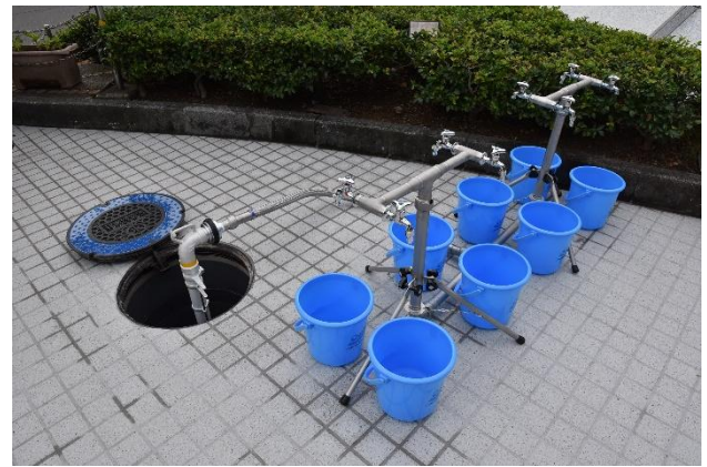
図-12 井戸に緊急用給水装置を接続
