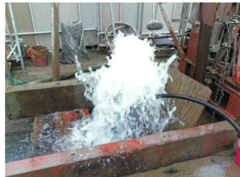
図-8 さく井箇所エアレーション状況
