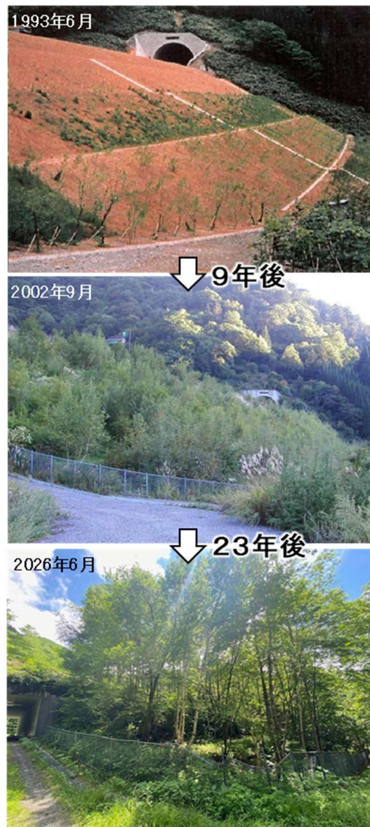
写真-1 盛土法面の経年変化
