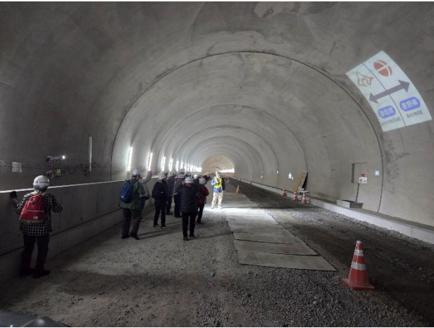
写真-2 青崩峠トンネル内の現場見学
