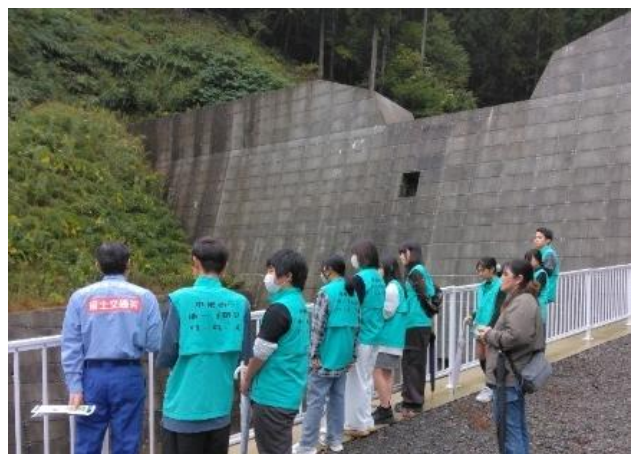
図-4 現地見学（ガラ山谷第1砂防堰堤）で体感
