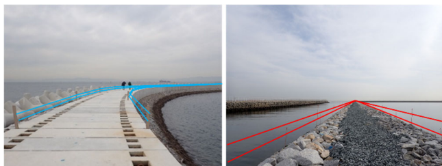
写真-7 護岸上テグス設置状況（設置位置は図-2）
