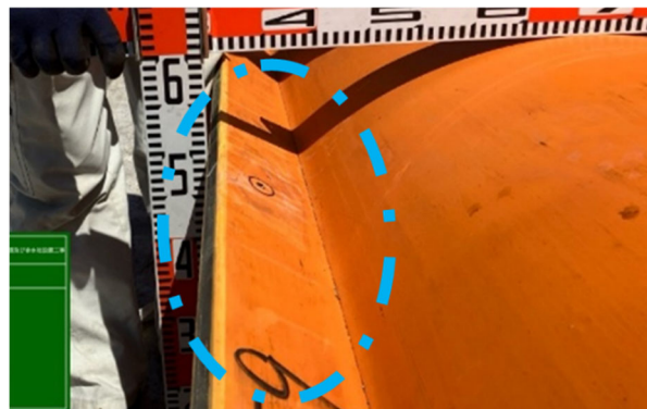
写真-9 汚濁防止膜 フロート上部の加工
