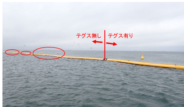
写真-10 汚濁防止膜 テグス設置効果比較
