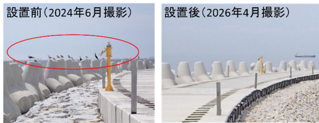
写真-14 バードソニック設置効果比較（左：設置前，右：設置後）設置前は消波ブロック上（赤丸箇所）に鳥が飛来している様子が見受けられる
