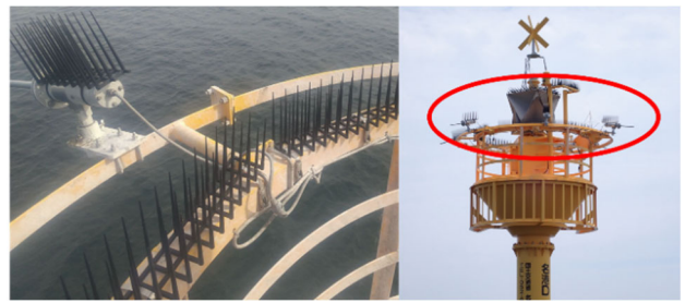
写真-12 浮体式灯標 防鳥剣山設置
