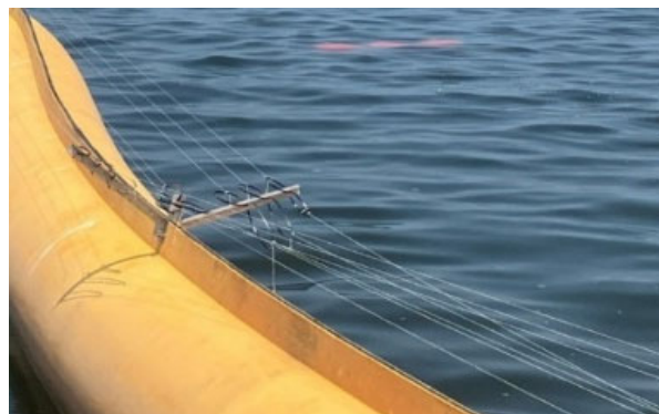
写真-8 汚濁防止膜 テグス設置状況（設置位置は図-3）
