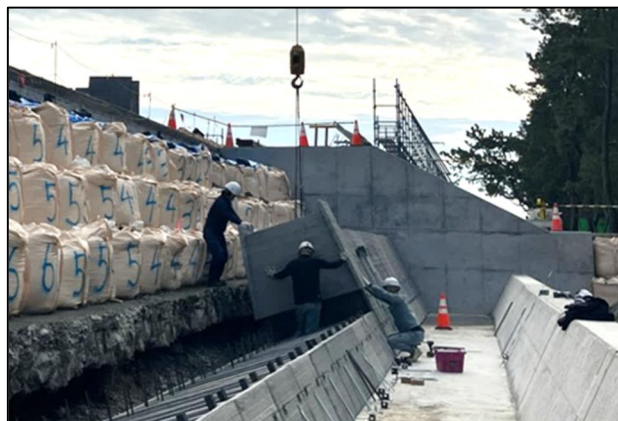
図－10 埋設型枠ブロックの据付状況
