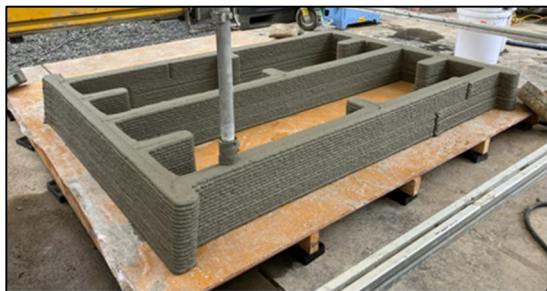
図－8 建設用 3D プリンターによる部材造形状況
