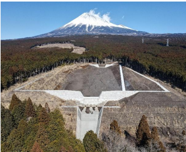
図-1 砂沢上流遊砂地工（静岡県富士市大淵）
