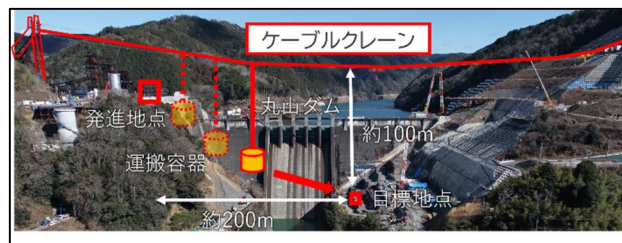
図3-5 ケーブルクレーンの動作イメージ
