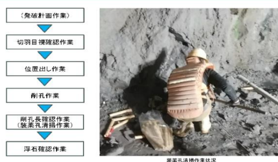
図-4 トンネル工事の施工フロー（穿孔）
