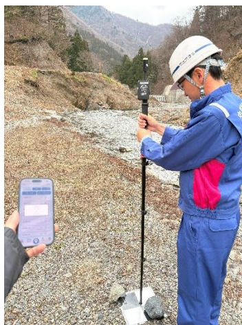
図-7 標定点（GCP）計測状況
