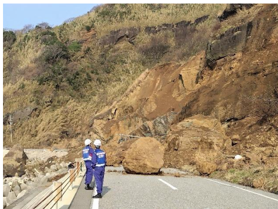
図-9 近接することが危険な調査箇所例
