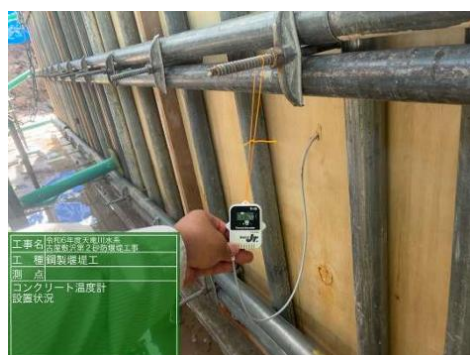
図-10 温度計設置状況
