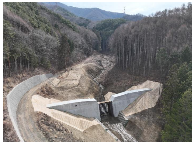
図-2 古屋敷沢第2砂防堰堤 砂防堰堤の高さ：9.5m 堤長：66m コンクリート打設量：2,050m 3
