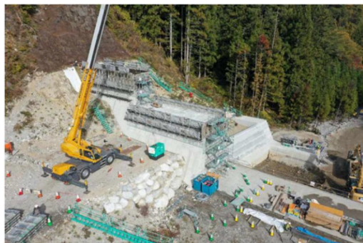
図-3 25tクレーンによる施工（従来施工）
