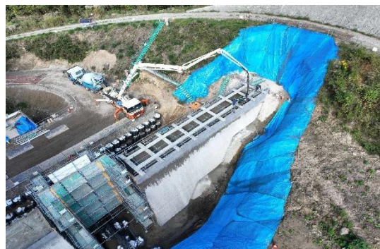
図-9 ポンプ打設状況
