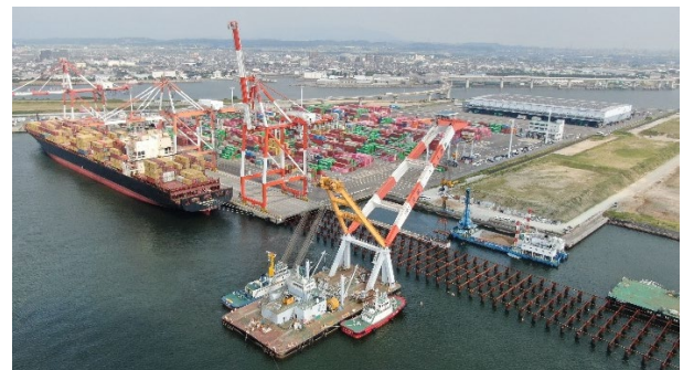
図-15 80号岸壁に船舶入港後の据付作業実施の様子
