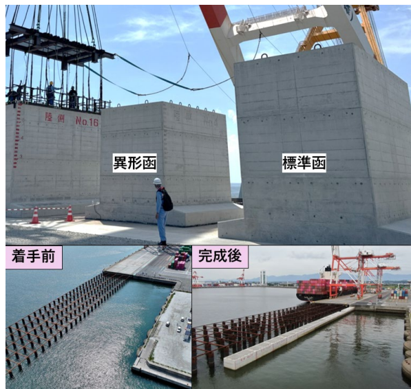
図-3 土留ケーソン（標準函・異形函）
