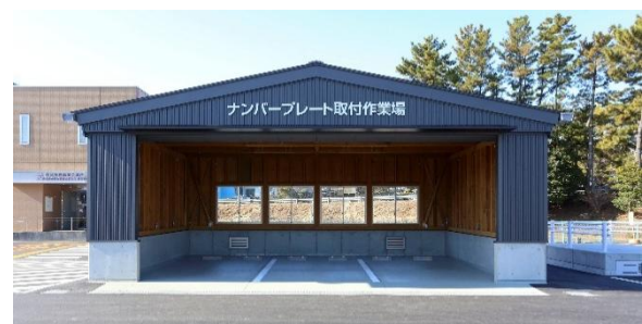
図-2 番号標取付作業上屋外観
