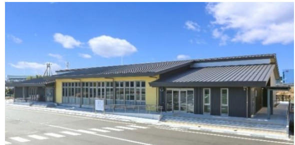
図-1 事務庁舎外観
