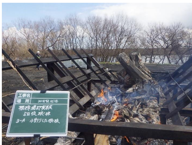
写真6 根株（除根5日後）焼却状況
