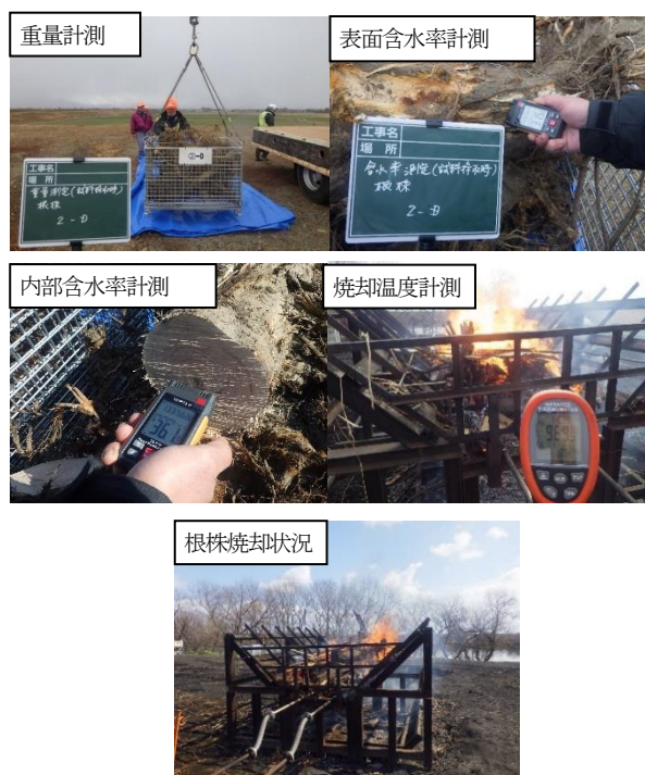
写真5 検証項目計測、根株焼却状況
