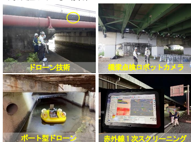
図-9 橋梁点検における点検支援技術の活用事例
