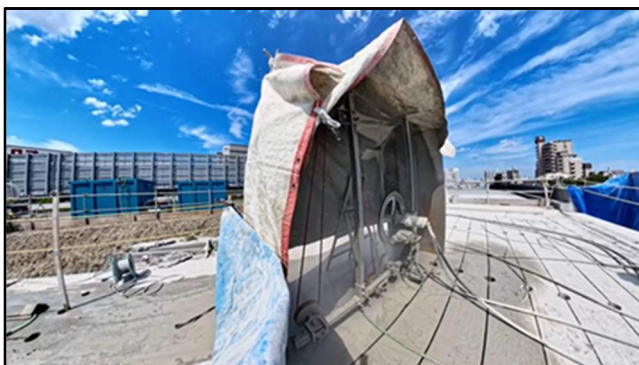
図-7 ワイヤーソー工法例（PC橋切断時）
