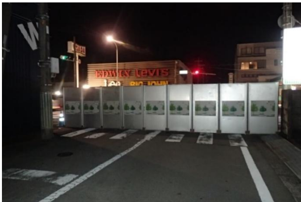
写真4 防音パネル設置状況
