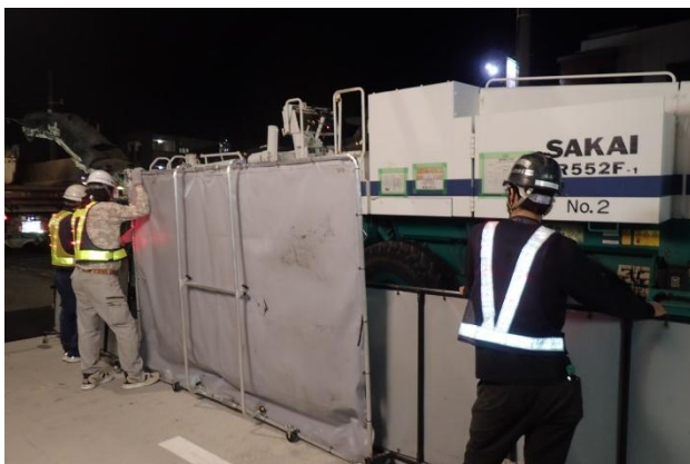
写真5 防音フェンス設置状況
