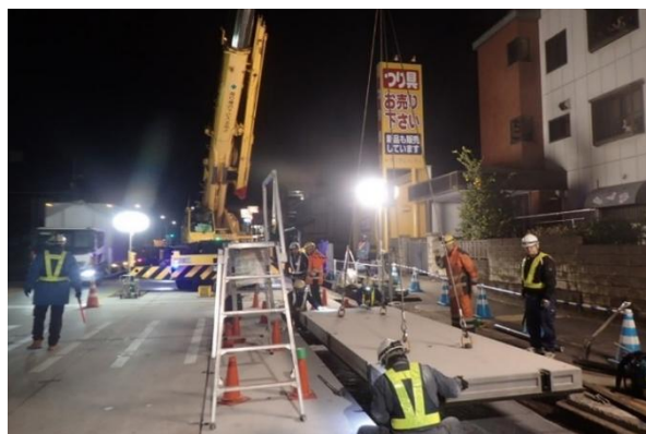
写真-3 PRC版設置状況
