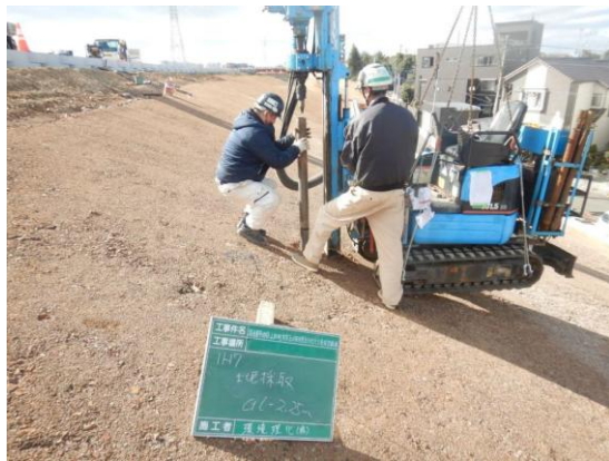
図-7 土壌汚染調査の様子
