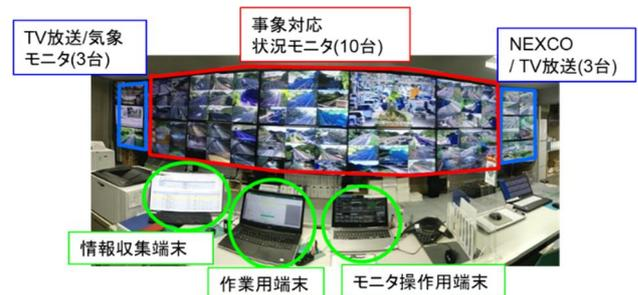
図-3 高規格道路管理センターにおける情報収集の状況
