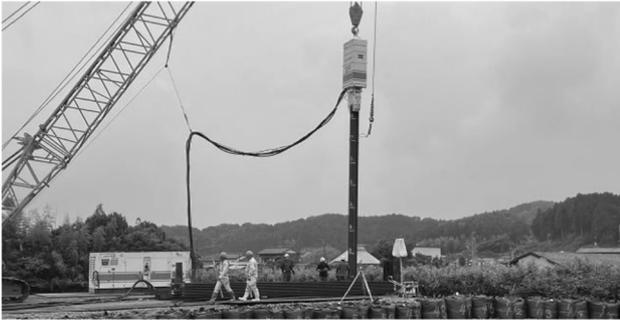
写真-6 6月15日 鋼矢板打設開始
