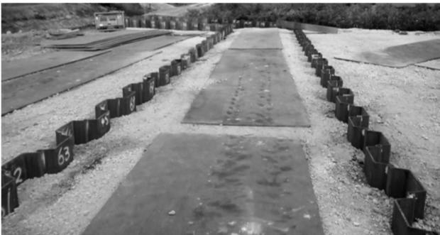
写真-7 6月21日 鋼矢板打設完了
