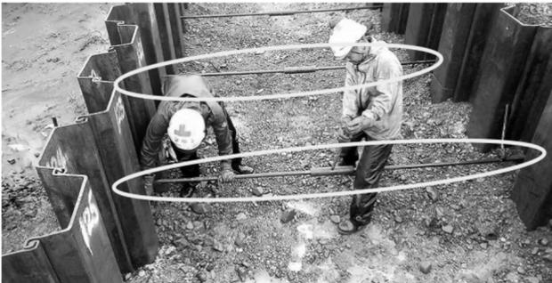
写真-8 7月1日 タイロッドの設置作業
