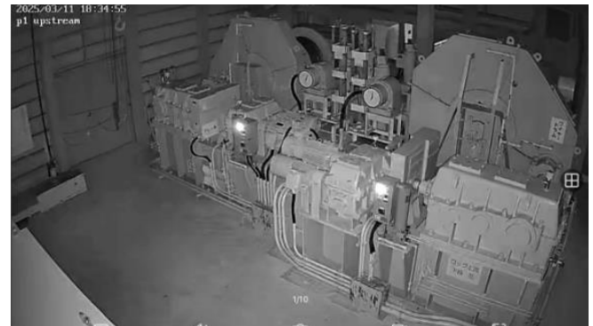
図-5 上屋カメラ映像②（夜間）
