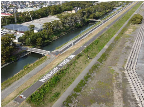
図 - 9 川尻工区（完成）
