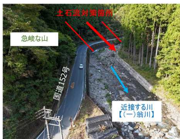
写真-1 対策箇所俯瞰写真
