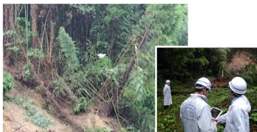
写真-3 UAVによる現地調査
