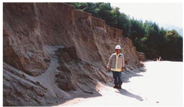
写真-1 東海（恵南）豪雨時の矢作ダム湖土砂異常堆積状況
