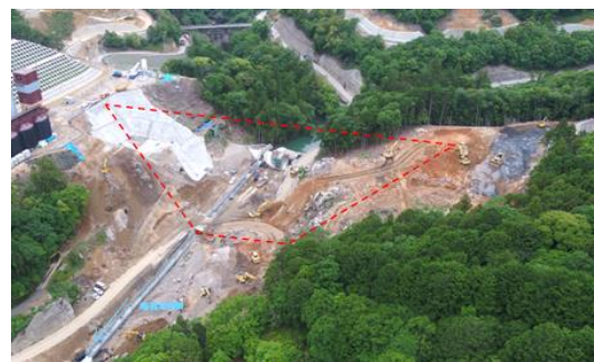
写真-1 ダム本体建設工事の施工状況（2025年5月）
