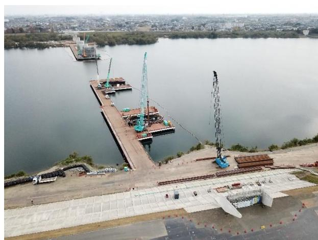
写真-1 下部工施工状況(2018 年 11 月)
