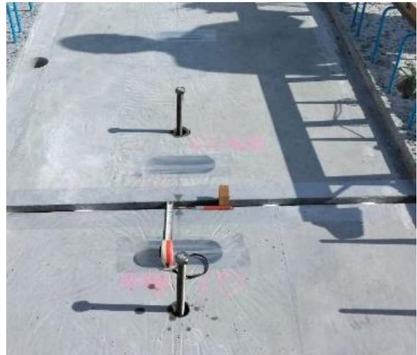
図-10 高さ調整ボルトによる床版設置高さ調整状況
