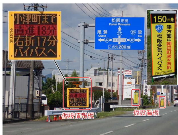
図-8 仮設情報板・仮設看板の設置状況（2022年度の内容）
